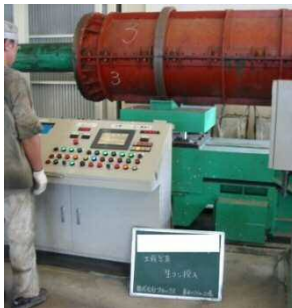
コンクリート投入
