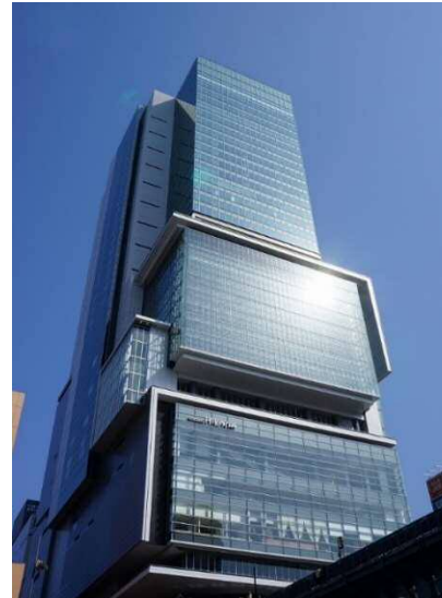
渋谷ヒカリエ (GRC 外壁)
