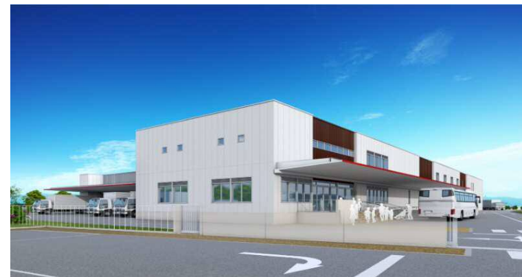
（写真：（仮称）四日市市学校給食センター整備運営事業）
