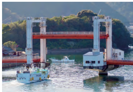
江ノ浦昇降橋※
