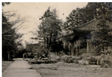
かつての國東寺。大きな建物が連なっていた※
