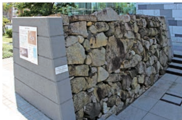
保存されている内堀の石垣
