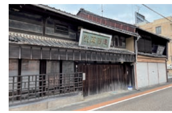
古い建物が点在する本町付近
