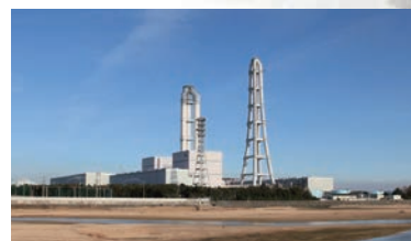
「川越火力発電所」遠景※
