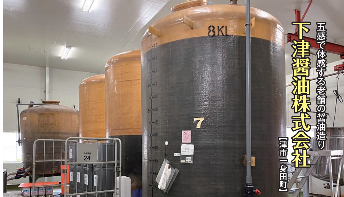
大きなタンクが並ぶ工場内
