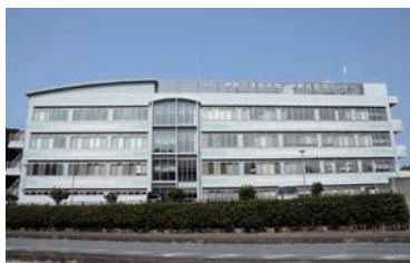
「伊勢市防災センター」外観
