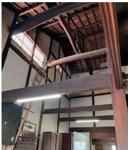
往時の繁栄ぶりを伝える主屋内部の様子
