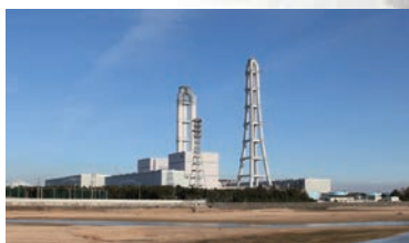
「川越火力発電所」遠景※
