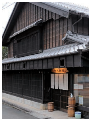
金川珈琲の外観(昔は呉服屋)
