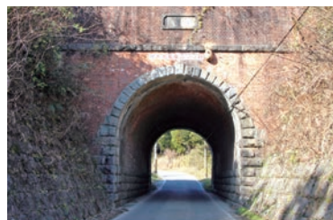
大和街道架道橋
