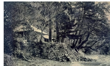
国道ができる前の西方寺※
