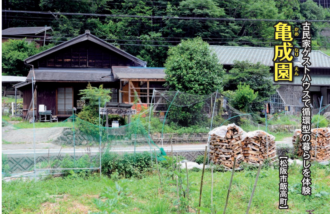
「亀成園」。黒い日本家屋が客室になる離れ
