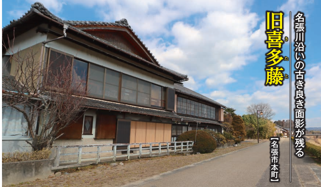
手前が大広間棟、奥に別館。名張川との間に堤防道路
