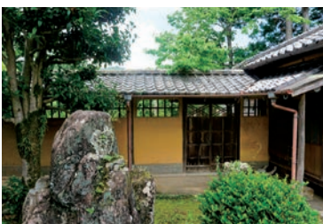
南蔵へと続く渡り廊下 ※
