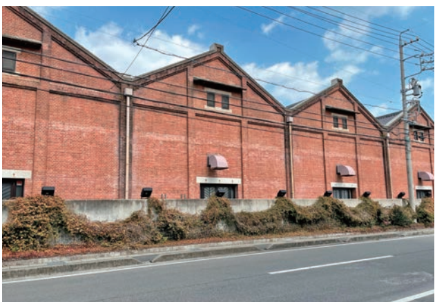
「旧東洋紡績株式会社 富田工場 原綿倉庫」(国登録有形文化財)
