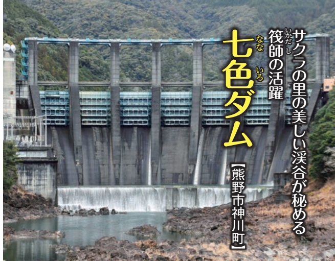
重力式コンクリートアーチダム
