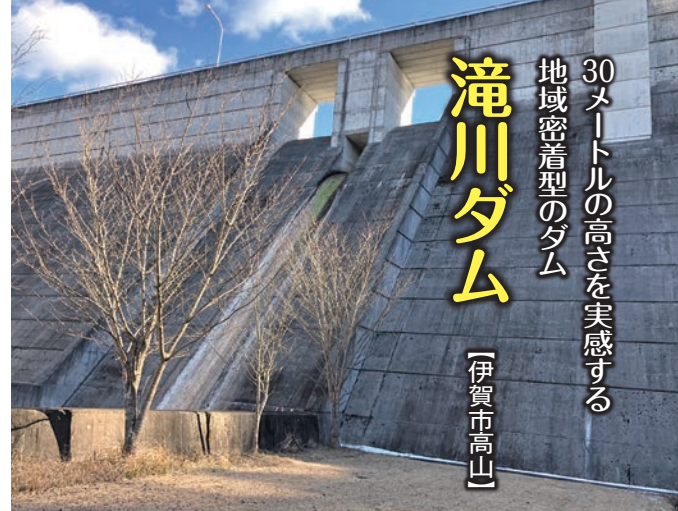
重力式コンクリートダム
