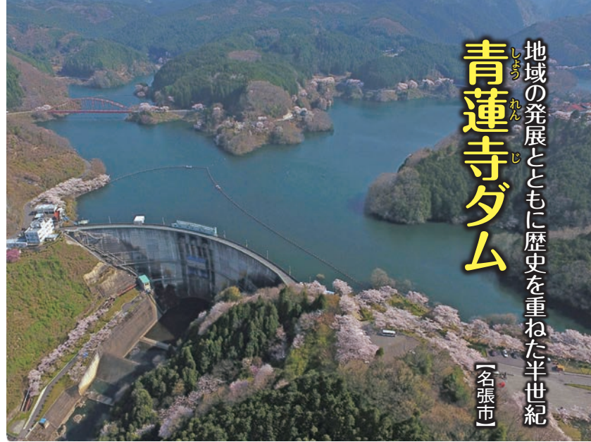
アーチ式コンクリートダム。「京セラドーム大阪」23個分の水が貯まる※
