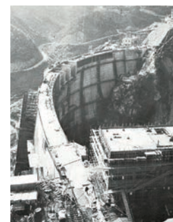
建設中の様子※
