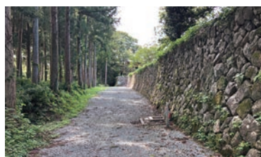
見事な石垣が続く延命寺周辺
