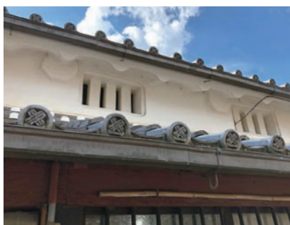
軒瓦に「違い鷹の羽根一つ引」
