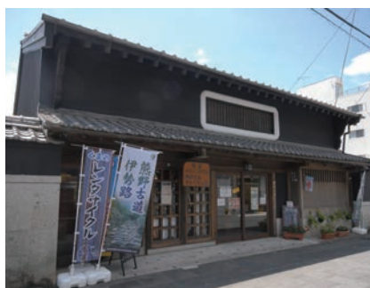
旧街道、本町通りに面した建物
