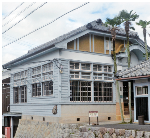
長谷園旧事務所・大正館(休憩スペース)
