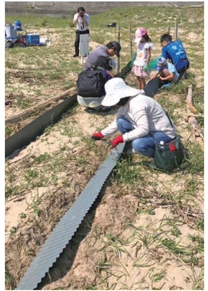
「ウミガメロード」設置作業※
