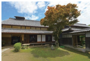
尾州廻船 内海船船主「旧内田家住宅」外観
