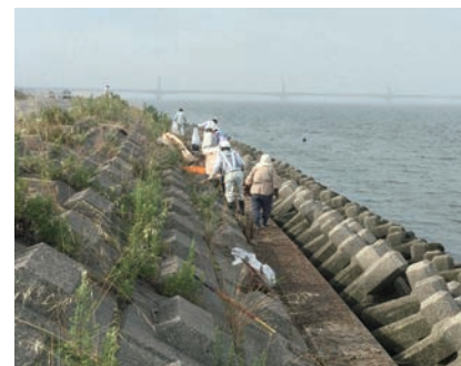
清掃作業の様子
