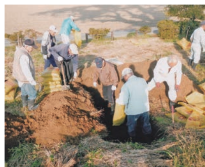
土壌改良の様子※
