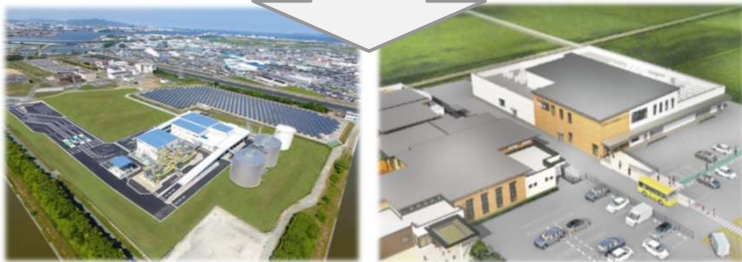
豊橋市バイオマス資源利活用設備 三重県伊賀市小学校給食センター
