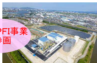
豊橋市バイオマス 資源利活用設備
