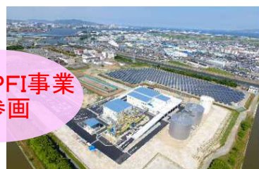
豊橋市バイオマス 資源利活用設備
